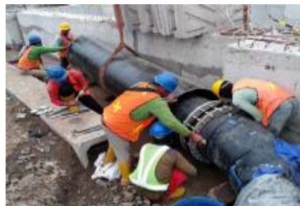
Gambar 8 Penyambungan Pipa HDPE dengan Alat Sambung Butt Fusion
