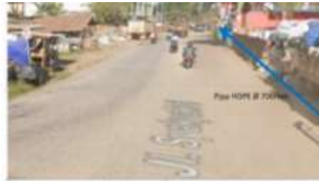
Gambar 9 Jalur Pemasangan Pipa Dimater 700 mm
