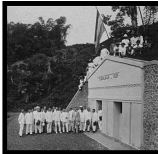
Gambar 3. Stadsgemeente Waterleiding Bandung, 1916-1928 (Sumber: Perumda Tirtawening)
