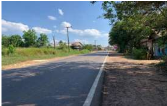
Gambar 8. Kondisi Jalan Pada KM.73+000
