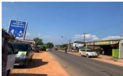
Gambar 10. Kondisi Jalan Pada KM.74+000
