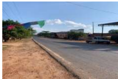
Gambar 12. Kondisi Jalan Pada KM.75+000
