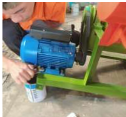
Gambar 19. Spesifikasi dan pemasangan motor Listrik Sumber: Analisa data pada PT. XYZ
