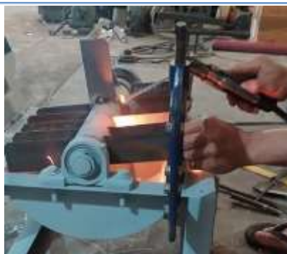
Gambar 17. Proses Pemasangan mata pisau Sumber: Analisa data pada PT. XYZ
