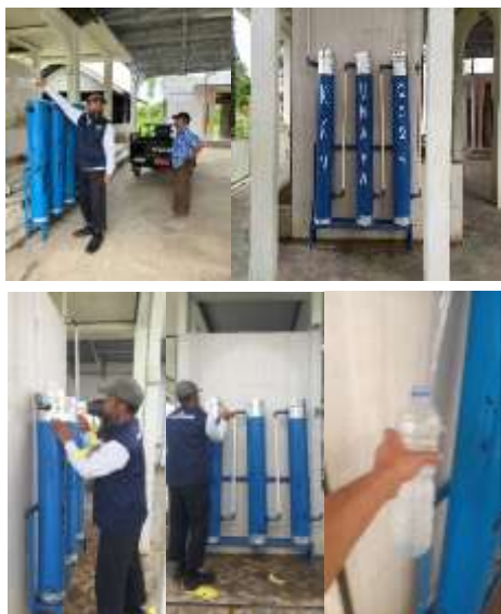
Gambar 6. Proses Pemasangan Unit Penyaringan Air dan Hasil Penyaringan
