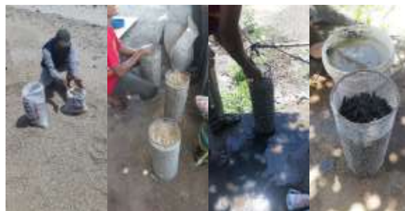
Gambar 5. Pengambilan Pasir dan Pengisian Material Utama Penyaringan Air
