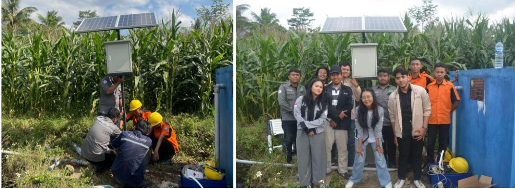
Gambar 7. Pemasangan panel surya oleh PT Sogy Energy Indonesia
