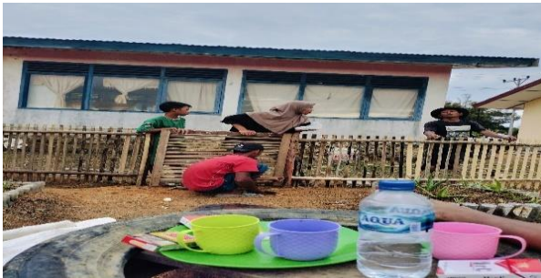
Gambar 5.b. Pembuatan pagar pada bagian depan dan pemasangan pintu masuk
