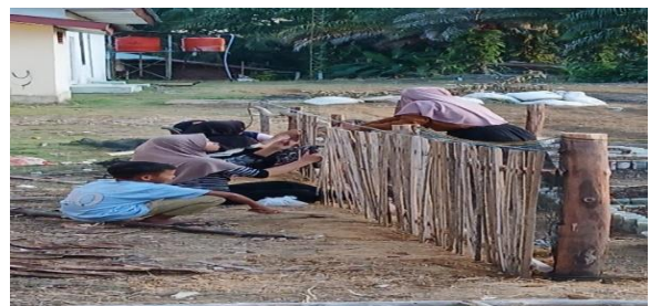
Gambar 5.a. Pembuatan pagar pada bagian depan dan pemasangan pintu masuk
