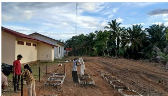
Gambar 3. Pemasangan Pancang Kayu untuk Pagar Keliling.
