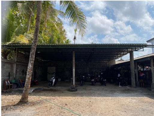
Gambar 10. Kondisi lokasi workshop batik sebelum renovasi
